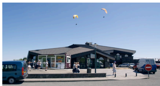
Maison de site au Puy de Dôme © LM/RGSF
