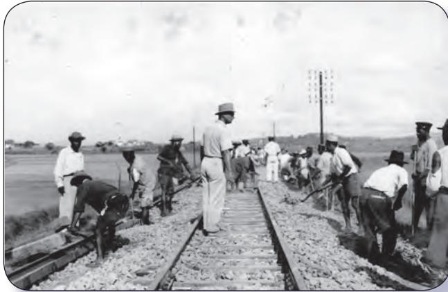
Travaux forcés pour la construction du chemin de fer : bourrage du ballast sous les traverses.
